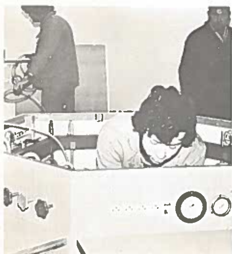
Au premier plan, M. COUSIN installant le dispositif de sécurité électrique.
