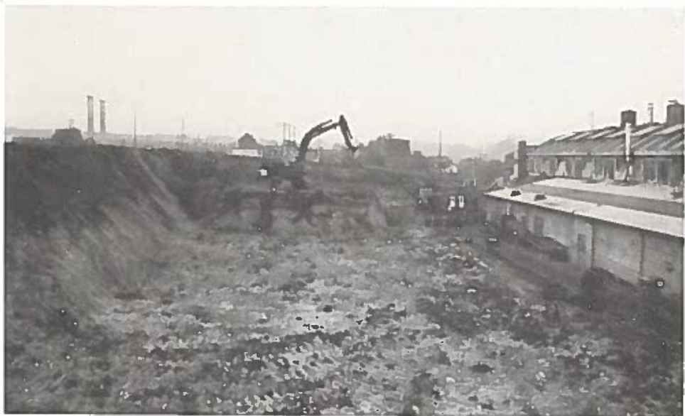
Une vue du chantier pendant les travaux de terrassement.
