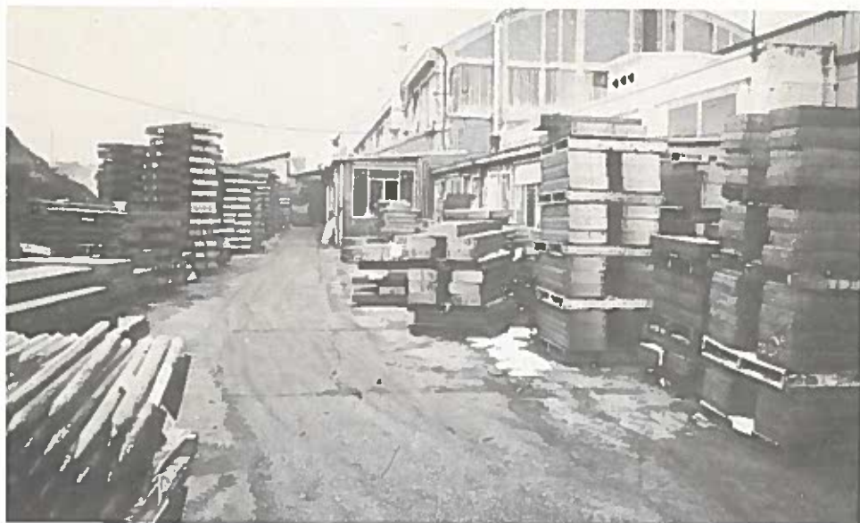
L'allée de circulation transformée en parc de stockage en attendant la fin des travaux.
